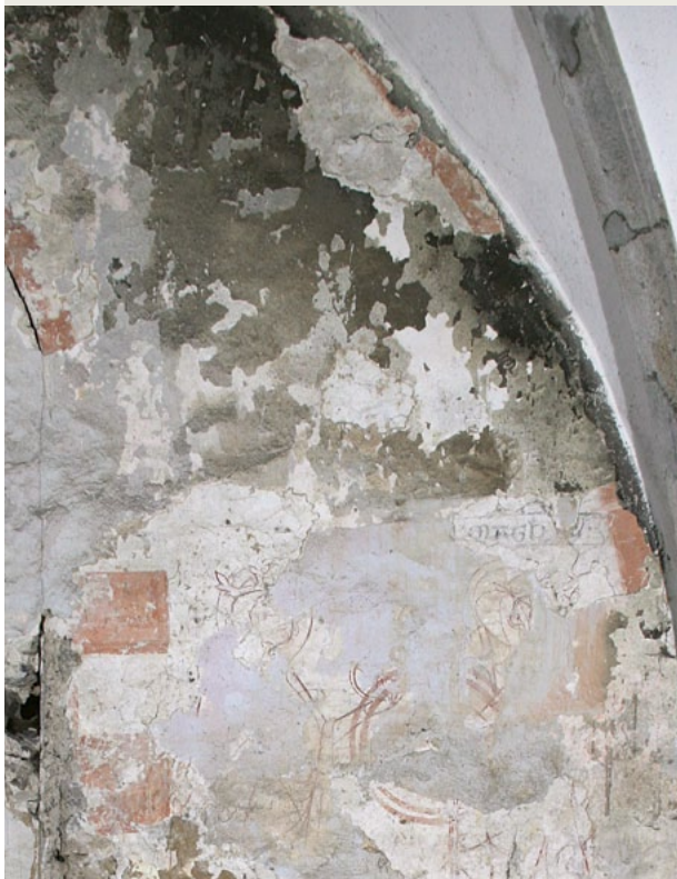
Ehemaliger Chorturm der ev. Pfarrkirche, Ober-Ohmen: Ausschnitt der Südwand vor und nach der Restaurierung unter Einbeziehung aufliegender jüngerer Putzschichten
